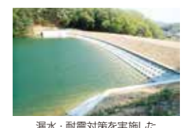
漏水・耐震対策を実施したため池(三木市)
