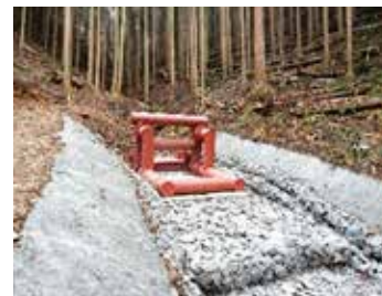
▲危険渓流での土砂・流木対策(姫路市)
