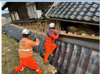
緊急消防援助隊兵庫県大隊 【2/16に輪島市へ派遣】
