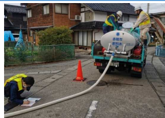
給水車(赤穂市) 【2/8に穴水町へ派遣】
