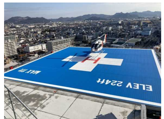
[屋上ヘリポート]
