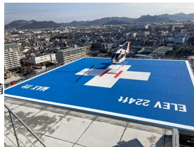
〔屋上ヘリポート〕
