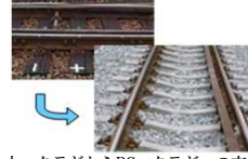
木クラギからPCクラギへの交換
