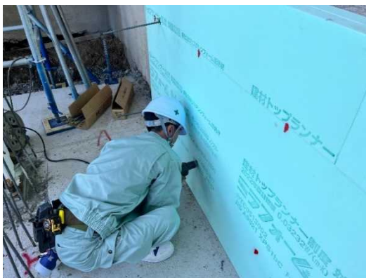
建築現場実習 (但馬技術大学校：建築工学科)
