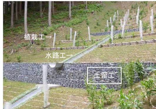
土留工と植栽工による山腹崩壊対策(丹波市)
