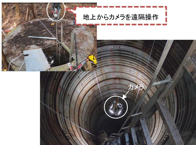
遠隔操作カメラによる集水井の点検(姫路市)
