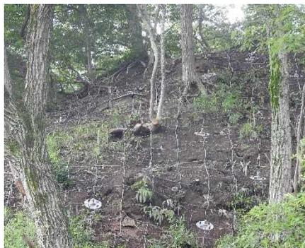
ロープネット・ロックボルト併用工法による立木を残した斜面防災対策(神戸市)
