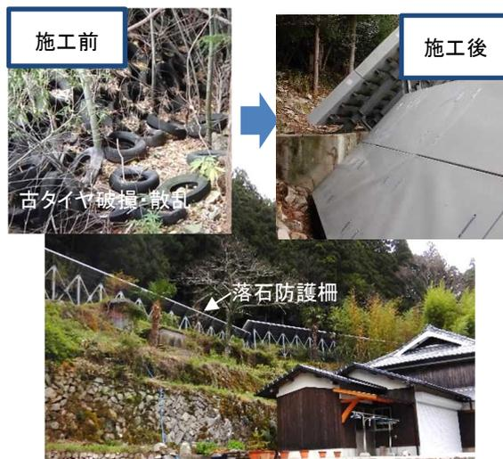
落石防護柵緩衝材の取替(神河町)
