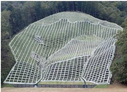
法枠工による山腹崩壊対策(宍粟市)
