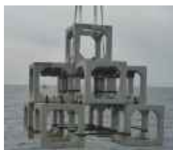
大型魚礁 (コンクリート組立魚礁)
