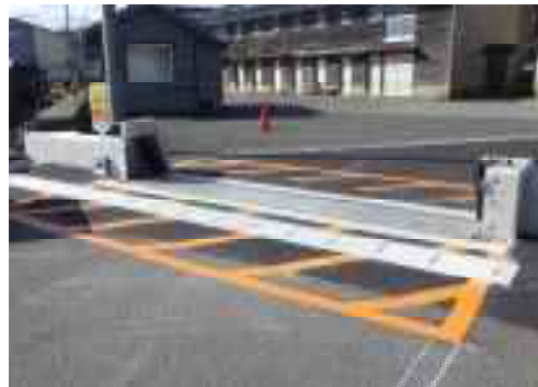
香住漁港 防潮堤(浮体式陸閘)整備後
