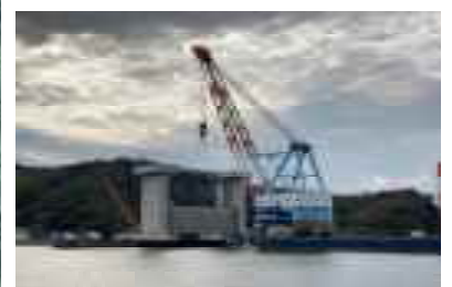
本港地区港口水門 施工状況
