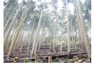
伐倒木を利用した土留工 (神河町)
