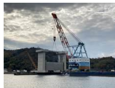
沼島港口水門施工状況(南あわじ市)
