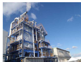
食品残渣等を利用した バイオマス発電施設（姫路市）
