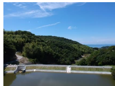
改修工事が完了したため池 (淡路市奥池)
