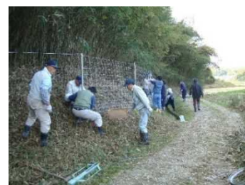
【被害管理】 獣害防護柵の設置
