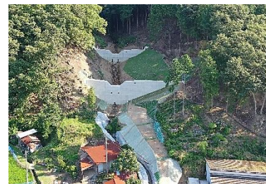
人家等を保全している治山ダム (養父市)
