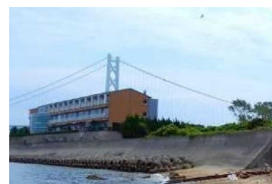
松帆崎海岸 防潮堤（淡路市）
