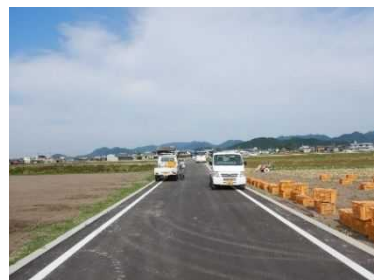
野菜の荷傷み防止のための農道舗装
