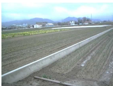
草刈り労力の軽減、病虫害抑制のための畦畔コンクリートの整備
