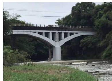
耐震整備が完了した淡河幹線水路 御坂サイフォン（三木市）
