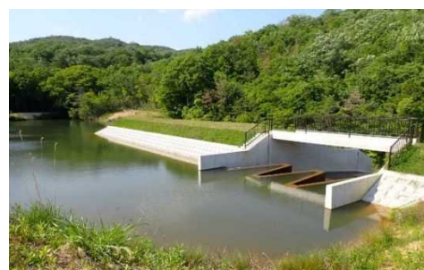
ため池改修完了（加東市 新池）
