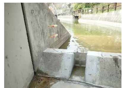
洪水吐切り欠きを活用した事前放流（高砂市 堂池）
