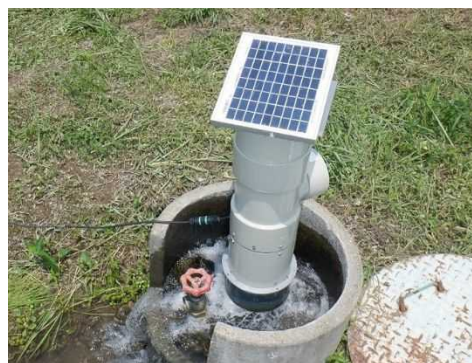
遠隔操作型自動給水栓（たつの市金剛山地区）
