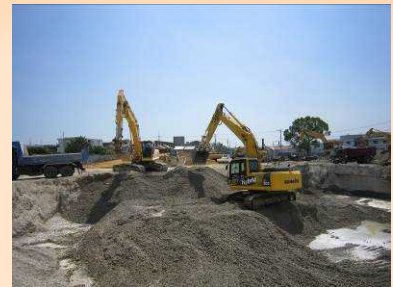
土壌汚染対策の実施現場
