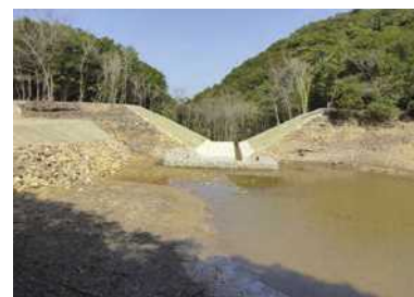
廃止工事が完了したため池(洲本市)
