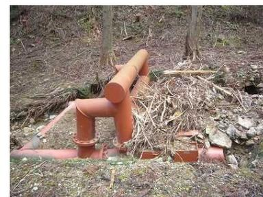
簡易流木止め施設による流木の捕捉（多可町）
