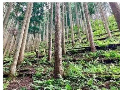
伐倒木を利用した土留工（養父市）
