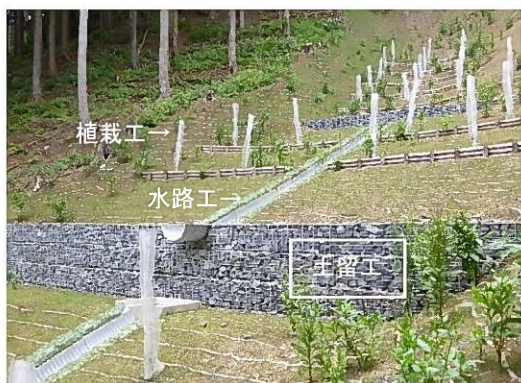
土留工と植栽工による山腹崩壊防止対策 (丹波市)
