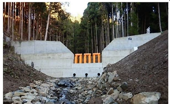
流木・土砂流出防止対策「ひょうご式治山ダム」
