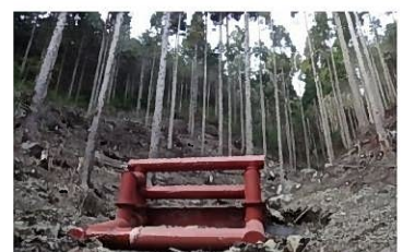
簡易流木止め施設の設置（丹波市）
