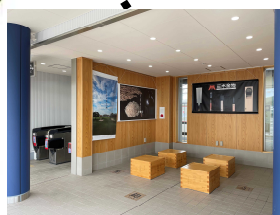
駅舎の内装木質化 (三木市)
