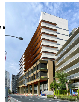
軒天を木質化した区役所 (神戸市)
