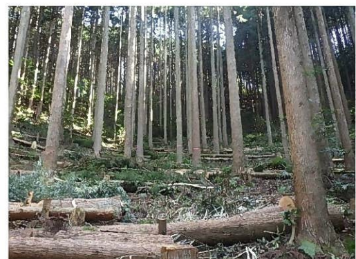
人工林での本数調整伐と伐採木を利用した土留工(朝来市)
