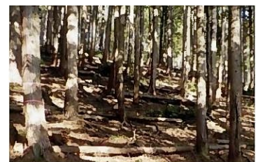
伐倒木を利用した土留工（香美町）
