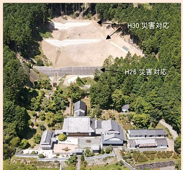
治山ダム工による復旧工事(丹波市)
