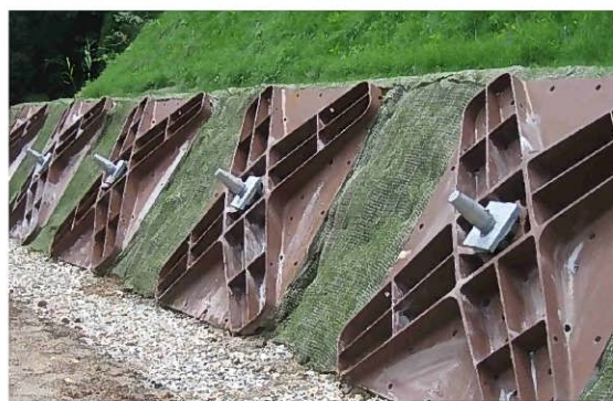
地すべりを抑止するアンカー工(香美町)
