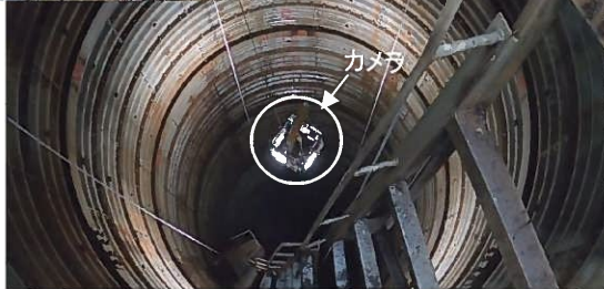
遠隔操作カメラによる集水井の点検(姫路市)
