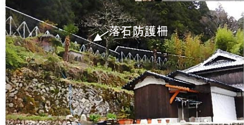
落石防護柵緩衝材の取替(神河町)
