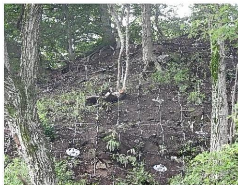
ロープネット・ロックボルト併用工法による 立木を残した斜面防災対策(神戸市)
