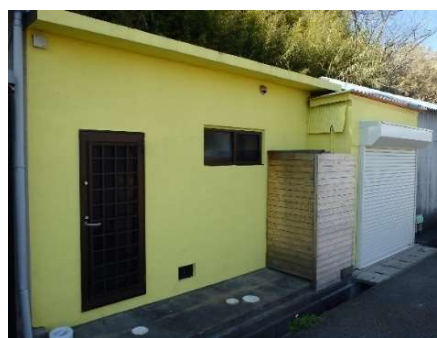
空き家を改修した農産物加工体験施設 (淡路市)
