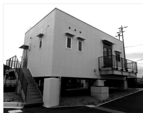
電気設備嵩上げ (掛保川第2工水第1ポンプ場)
