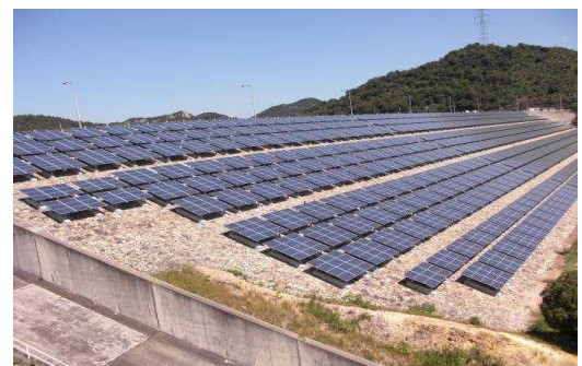
ダム堤体法面の有効活用（権現ダム）
