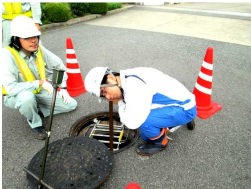
音聴による漏水調査
