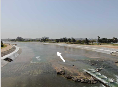
河床掘削に先立つ護岸整備 武庫川（尼崎市・西宮市）
