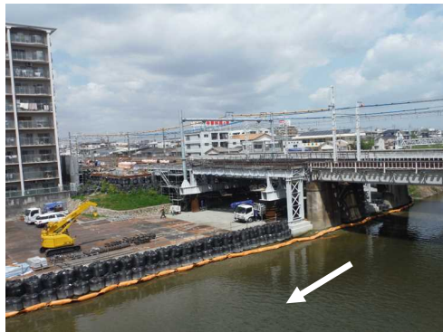
JR橋梁改築 明石川（明石市）
