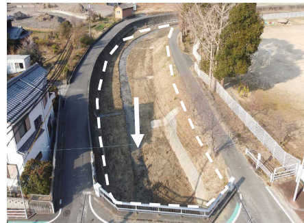
堆積土砂撤去 生穂川（淡路市）
