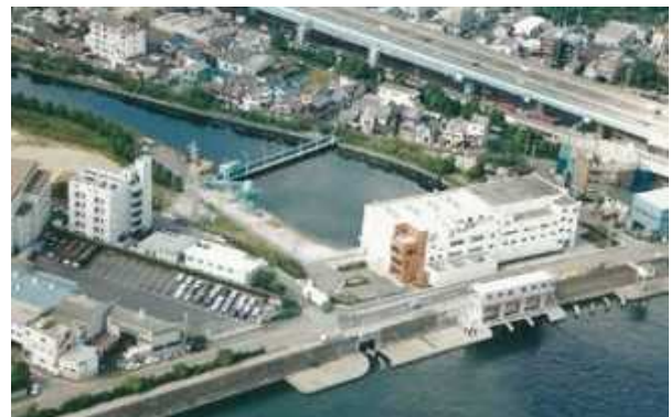
松島排水機場（尼崎市）
