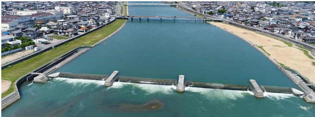
ゴム堰補修 市川潮止堰（姫路市）
