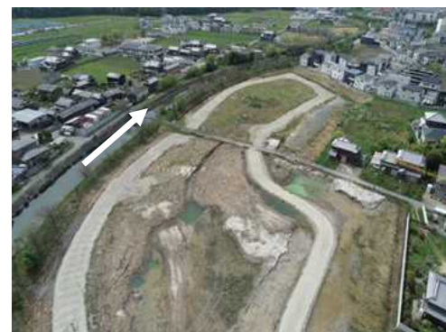
調節池整備 八家川（姫路市）
