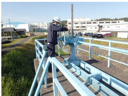
樋門点検 武庫川(三田市)
