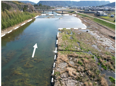
河床掘削 加古川（西脇市）
