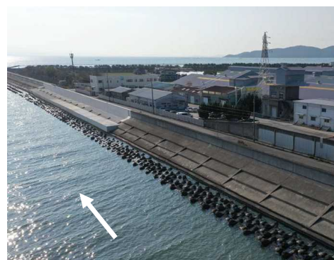
防潮堤の補強 千種川(赤穂市)
