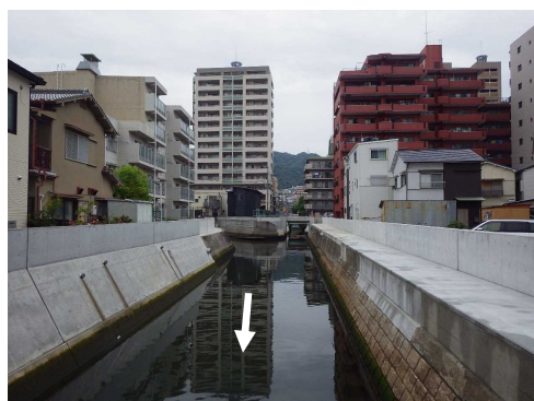
緊急対策完了 高橋川(神戸市)
