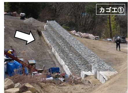
土砂流出予防工事（完了時）
