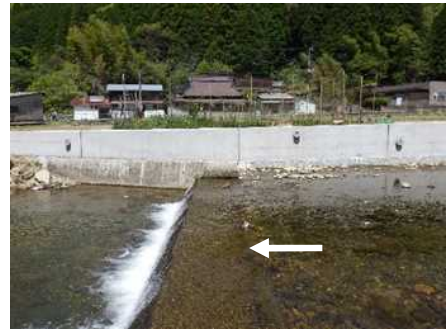
堤防かさ上げ しづみがわ 志文川（宍粟市）
