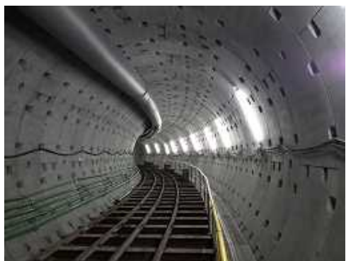
地下貯留管整備 津門川（西宮市）
