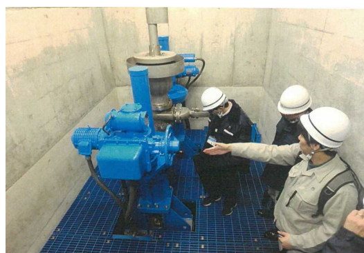
放流ゲート点検 石井ダム(神戸市)
