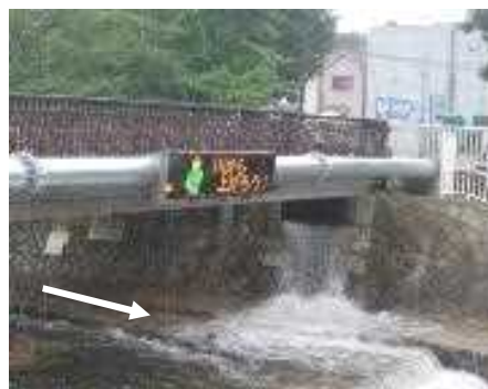
電光掲示板(甲橋) かぶとぼし (増水時の状況)
