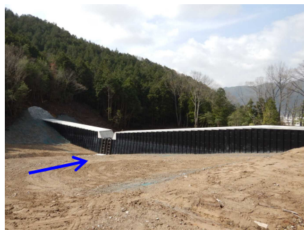
砂防ソイルセメント工法の事例 福本上谷川堰堤（神河町）（令和4年度完成）
