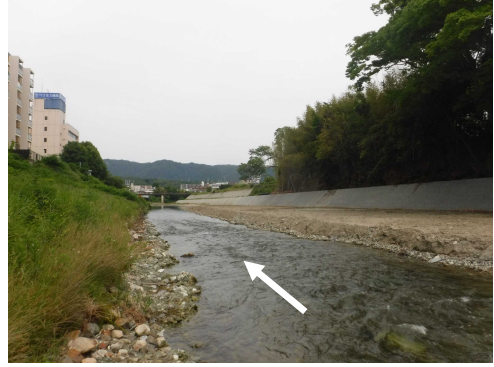
護岸整備 猪名川（川西市）
