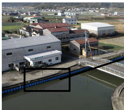
老朽化対策（被覆防食）
