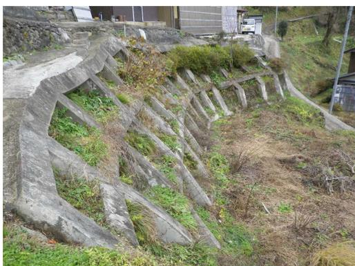
アンカー工が変状するなど災害防止機能が低下（対策前）
