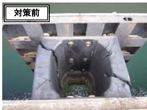
【播磨地区(-12m 岸壁 防舷材損傷)】
