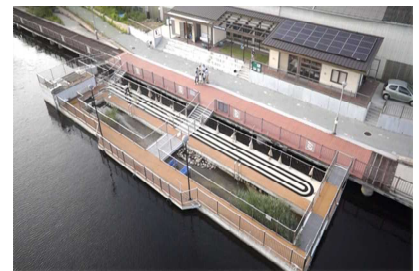
【北堀運河(水質浄化施設)】
