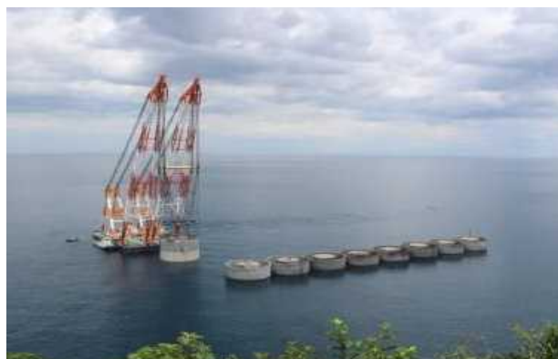
【柴山港(防波堤)】
