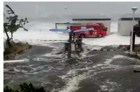
【南芦屋浜南護岸 越波状況】
