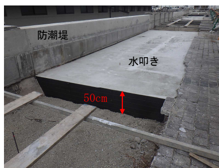
【洲本港海岸(水叩きの補強)】
