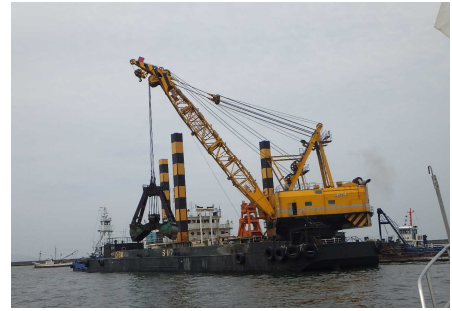
【姫路港(-12m 航路・泊地浚渫)】
