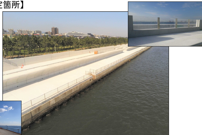
【南芦屋浜南護岸（整備状況）】
