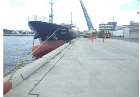
【姫路港中島地区(-5.5m 岸壁)】
