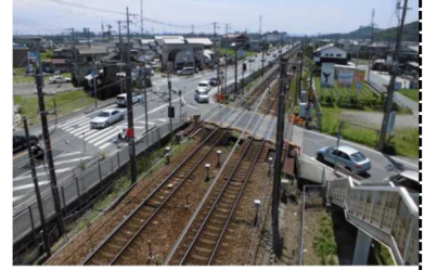
工事前の柵田踏切・柵田交差点
