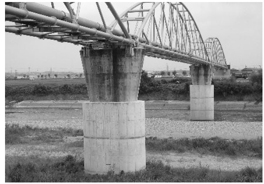
水管橋の耐震補強(加古川横断共同橋)
