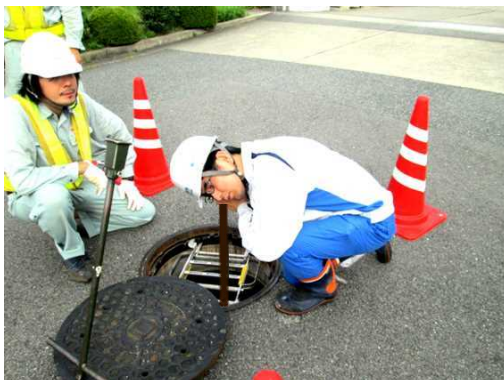
音聴による漏水調査
