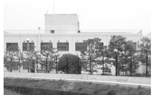
浸水防止用擁壁(船津浄水場)
