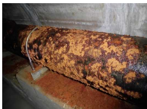
施設の劣化状況（左：送泥管の腐食 右：雨水沈殿池掻寄機の腐食）
