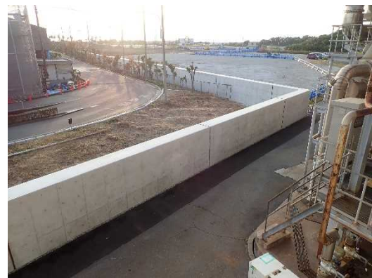
兵庫東流域下水汚泥広域処理場
