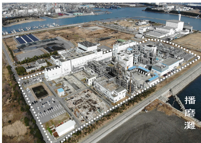
兵庫西流域下水汚泥広域処理場 全景
