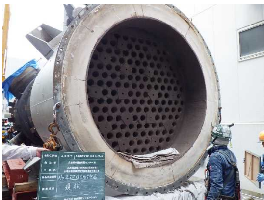
兵庫西流域下水汚泥広域処理場 空気予熱器長寿命化
