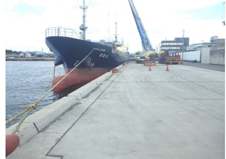
【姫路港中島地区(-5.5m 岸壁)】
