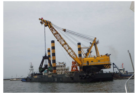
【姫路港(-12m 航路・泊地浚渫)】
