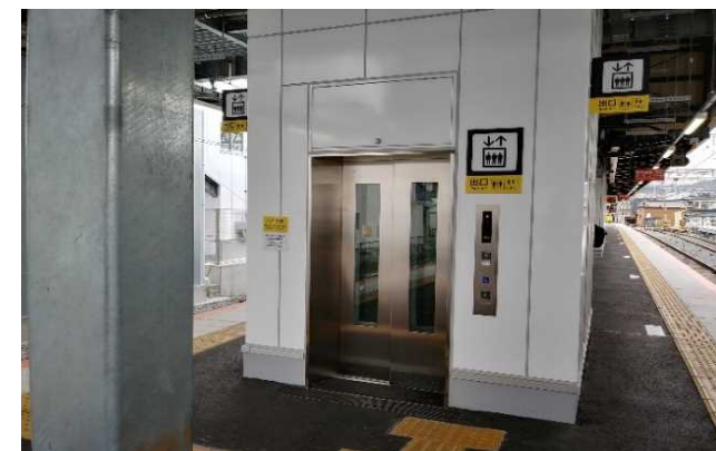
エレベーター設置（山電大塩駅）
