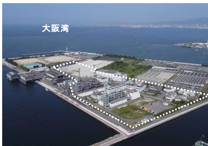
兵庫東流域下水汚泥広域処理場 全景
