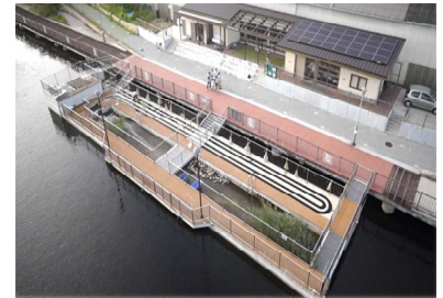
【北堀運河(水質浄化施設)】
