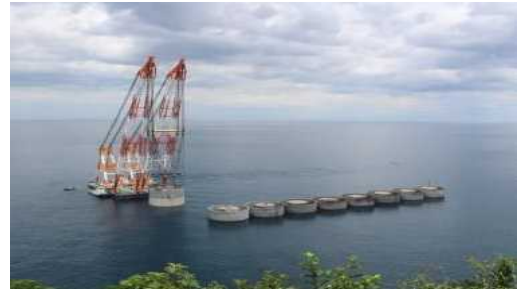
【柴山港(防波堤)】
