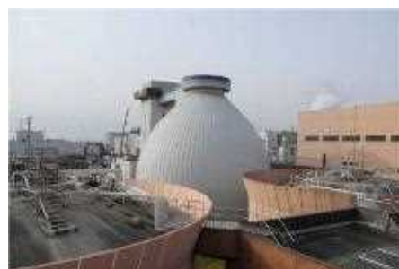
下水汚泥消化施設 （原田処理場）
