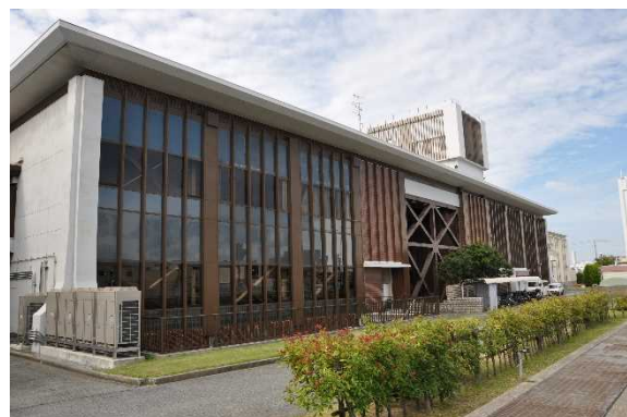
管理棟耐震化(武庫川下流浄化センター)
