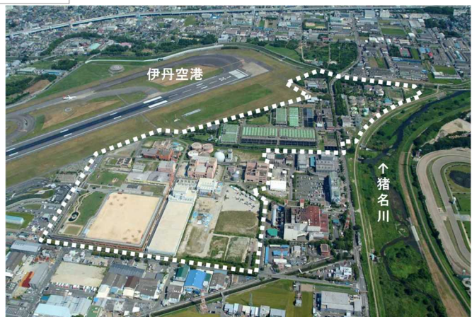
原田処理場 全景
