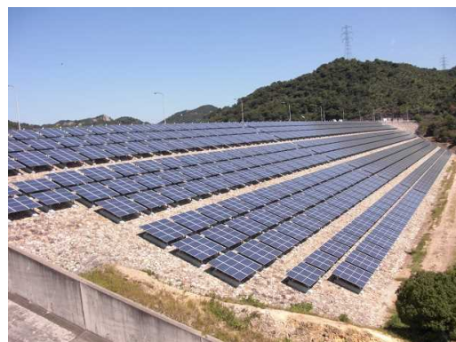
【権現ダム堤体法面】
