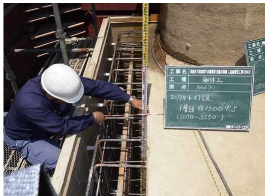
人孔耐震化(武庫川下流流域下水道)
