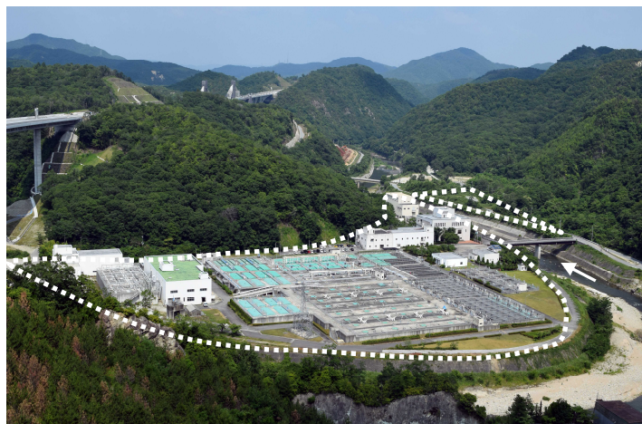
武庫川上流浄化センター 全景
