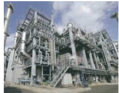
3号焼却炉 外観
