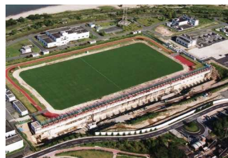
処理場上部空間を利用した多目的広場 （加古川上流浄化センター）
