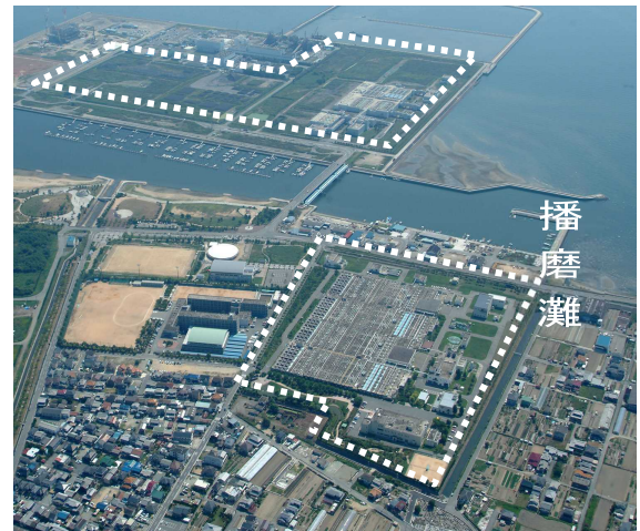
揖保川浄化センター 全景
