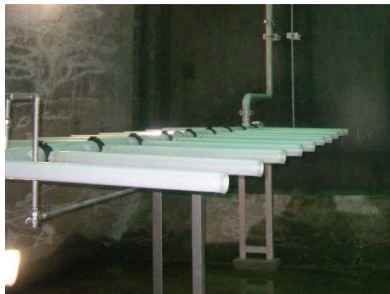
武庫川上流浄化センター 生物反応槽散気装置更新
