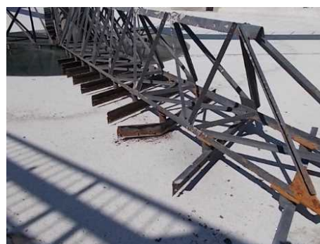
施設の劣化状況（左：送泥管の腐食 右：雨水沈殿池掻寄機の腐食）
