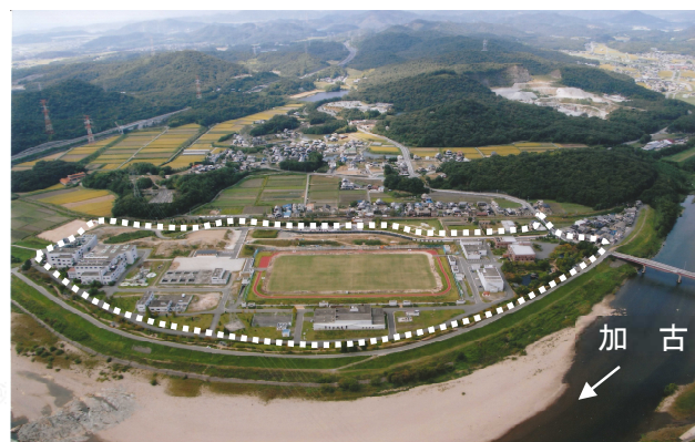
加古川上流浄化センター 全景
