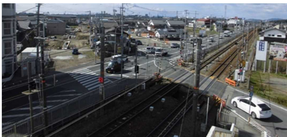
施工前 棚田踏切・交差点 (英賀保駅周辺地区)
