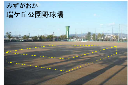
雨水貯留施設（伊丹市）
