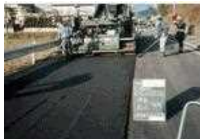
溶融スラグを活用したアスファルト舗装 （兵庫西流域下水汚泥広域処理場）
