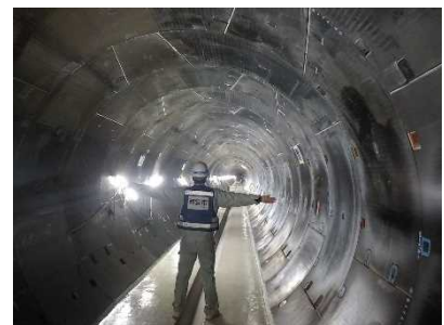
雨水貯留管（西宮市）
