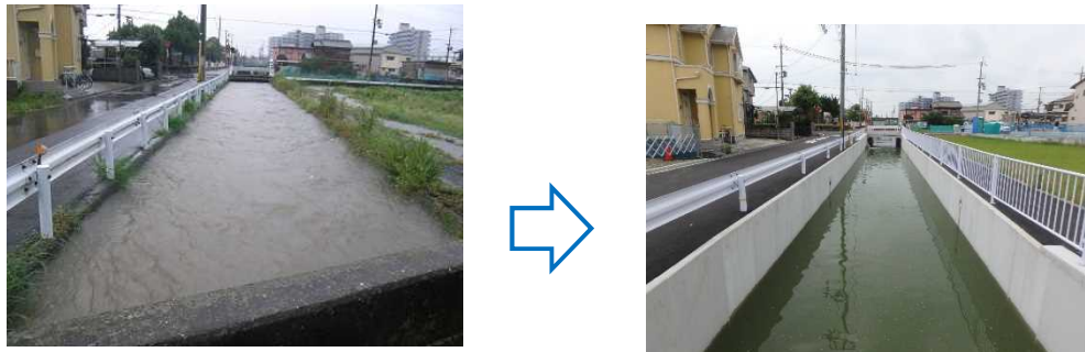
雨水幹線整備（加古川市）
