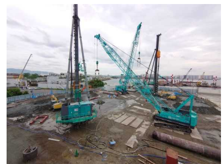
基礎工事 施工状況 (兵庫東流域下水汚泥広域処理場)
