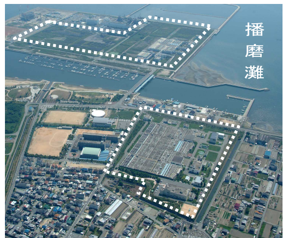
揖保川浄化センター 全景
