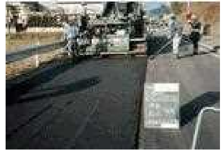
熔融スラグを活用したアスファルト舗装 （兵庫西流域下水汚泥広域処理場）
