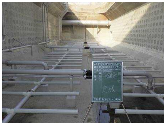
武庫川下流浄化センター 生物反応槽散気装置更新
