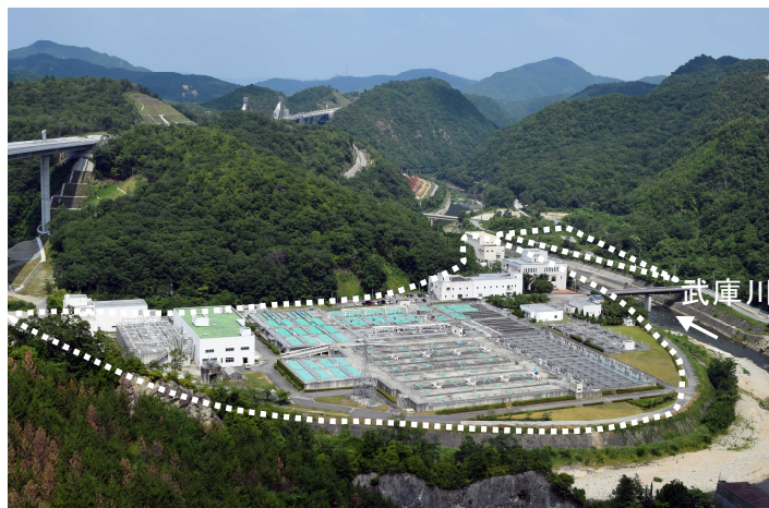
武庫川上流浄化センター 全景
