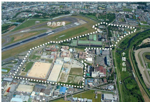
原田処理場 全景
