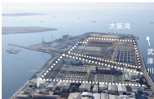
武庫川下流浄化センター 全景
