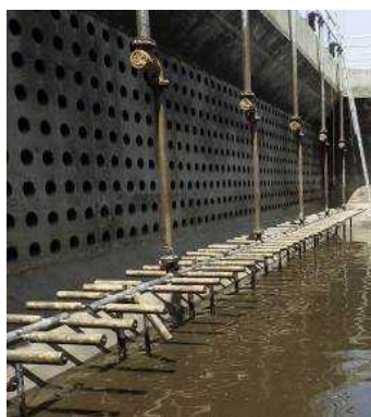
武庫川下流浄化センター 生物反応槽散気装置更新
