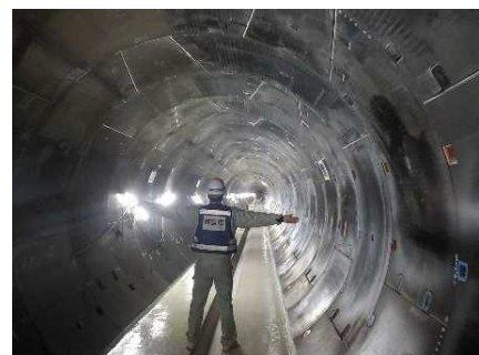
雨水貯留管整備（西宮市）
