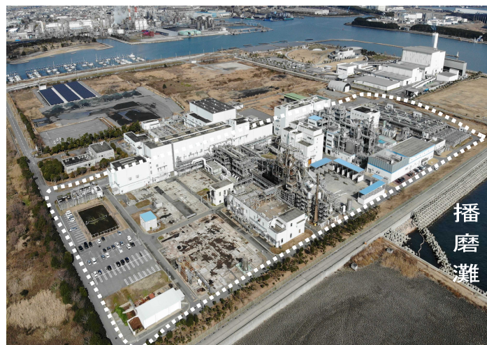
兵庫西流域下水污泥広域処理場 全景
