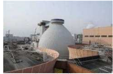
下水汚泥消化施設 （原田処理場）
