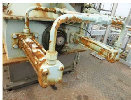
施設の劣化状況 (左：ポンプ内部の腐食 右：し渣乾燥機の腐食)
