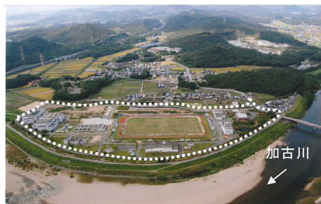
加古川上流浄化センター 全景
