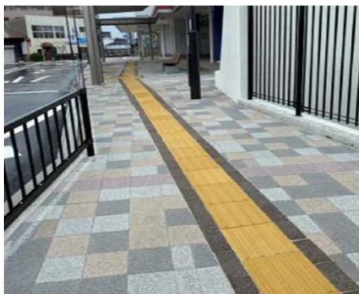
助言の例①：点字ブロック周囲の コントラスト
