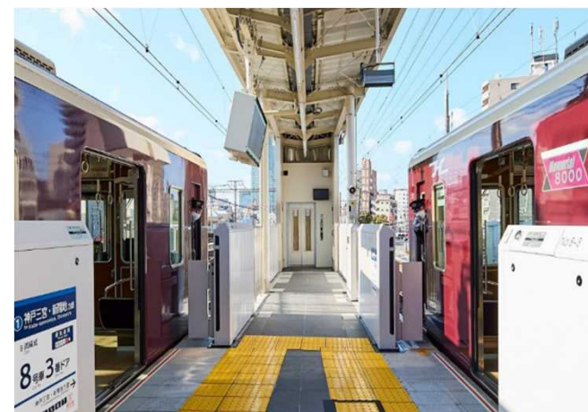
エレベーター設置 (阪急春日野道駅)
