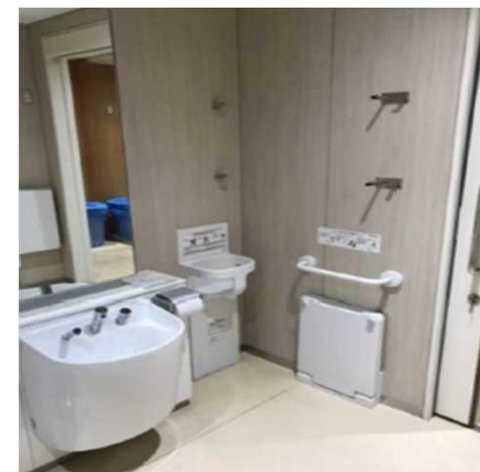
助言の例②：車椅子対応トイレ のフック（2箇所）
