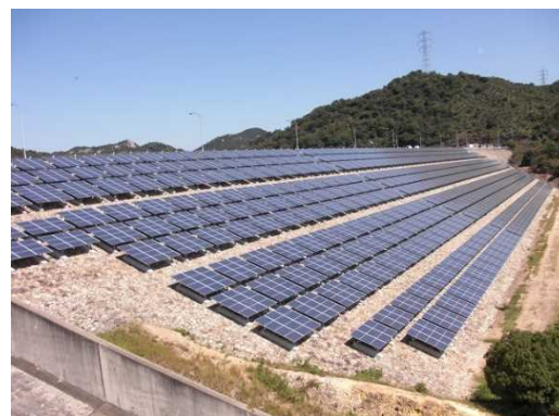
【権現ダム堤体法面】
