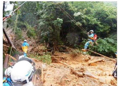
【土砂災害現場での活動状況（宍粟市）】
