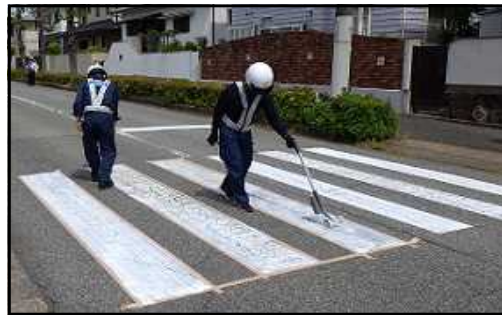
【機動補修班による横断歩道の補修】
