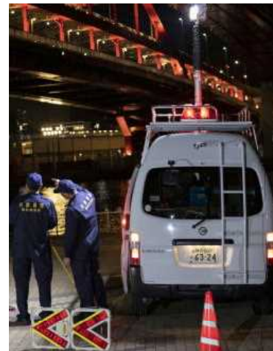
【投光車による現場支援状況】
