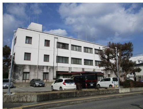
【長寿命化改修予定のたつの警察署】
