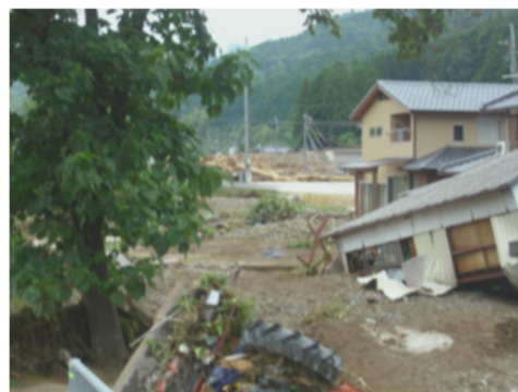
【土砂災害の被害状況】
