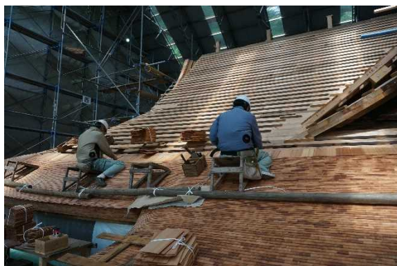
名草神社本殿及び拝殿建造物保存修理
