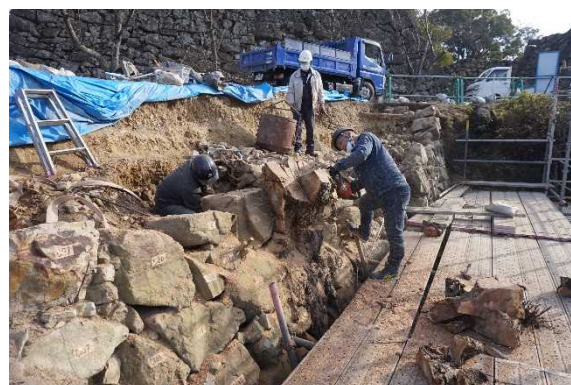
洲本城跡歴史生き生き史跡等総合活用整備 (石垣修理)
