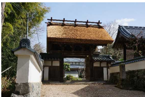
徹心寺山門保存修理（屋根葺替）
