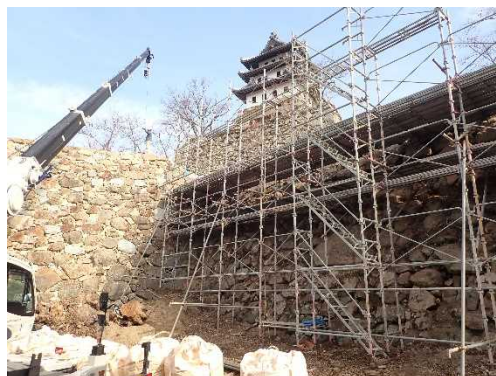
洲本城跡保存修理（石垣解体）
