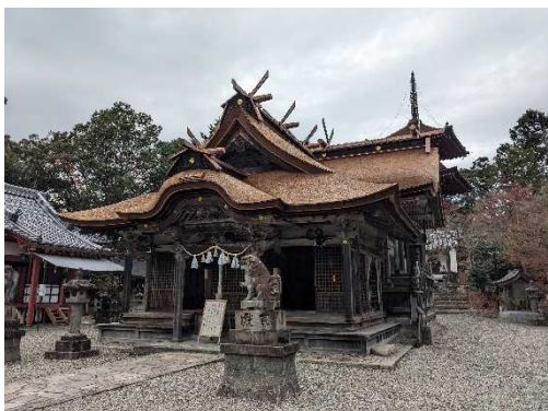
柏原八幡神社本殿及び拝殿保存修理（屋根葺替）
