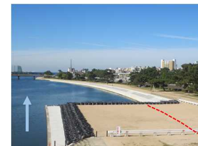
武庫川 河川改修
