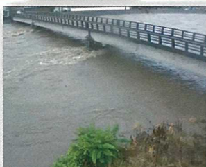
河川監視カメラ
