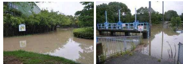
間の川の出水状況写真
