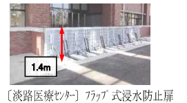
[淡路医療センター] 777A式浸水防止扉
