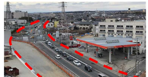
国道2号（和坂地区）施工状況
