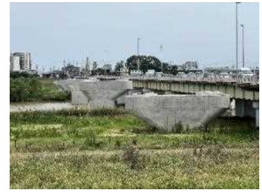
国道2号（加古川橋工区）施工状況
