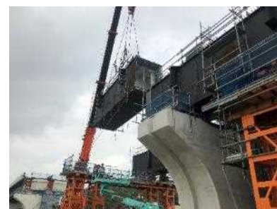
東播磨道北工区(下村第5高架橋)施工
