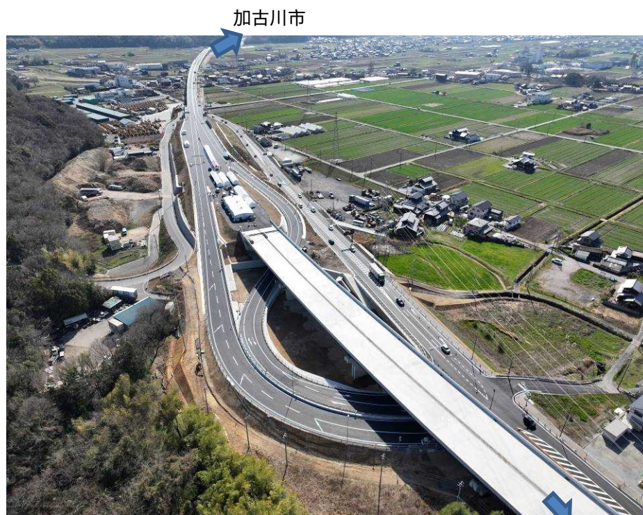
【八幡三木ランプ】 (令和5年3月19日撮影)
