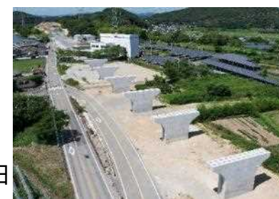
東播磨道北工区(宗佐高架橋)施工状況
