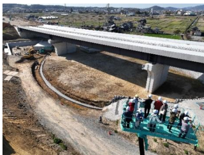
東播磨道 工事現場
