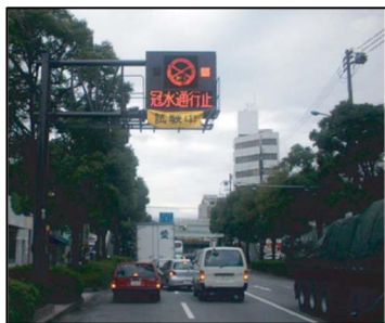
冠水情報板の設置
