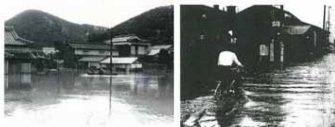
昭和 38 年 6 月の浸水状況【姫路市妻鹿地区】
