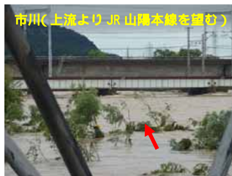
平成23年台風12号浸水状況写真
