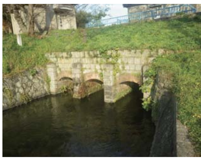
飾磨樋門(大樋)
