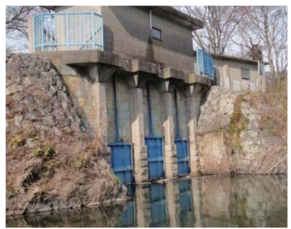
飾磨樋門(大樋)
