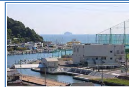
八家川排水機場
