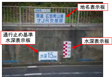
冠水対策用表示板の設置 (水深表示板・地名表示板)
