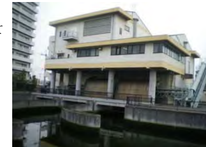
野田川排水機場
