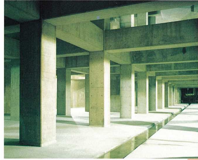
雨水貯留施設のイメージ
