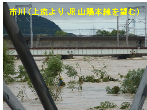
平成23年台風12号浸水状況写真
