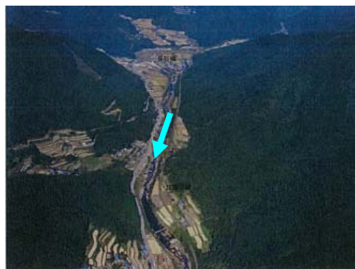
市川 長谷橋 神崎郡神河町栗付近
