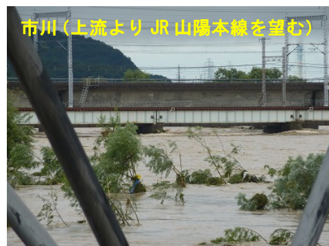
平成23年台風12号浸水状況写真
