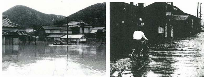
昭和 38 年 6 月の浸水状況【姫路市妻鹿地区】
