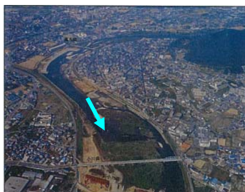
市川 小川橋 姫路市花田町高木付近
