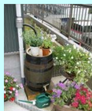
個人宅に設置された雨水タンク
