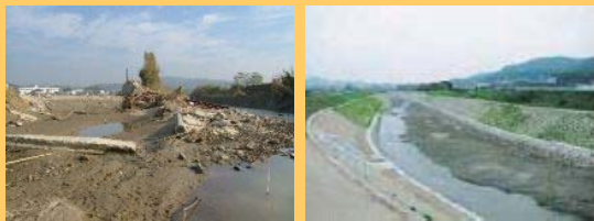
平成16年台風23号による大雨で被災した洲本川 （左：被災直後 右：事業実施後）
