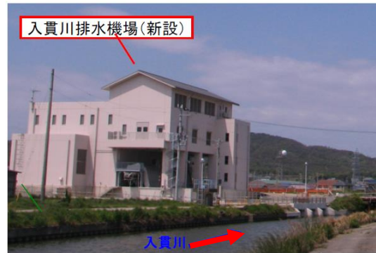
入貫川排水機場（南あわじ市松帆地内）
