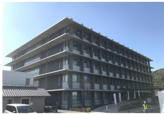
図 48 洲本総合庁舎の建物嵩上げ
