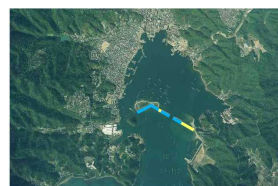
南側+北側新設
