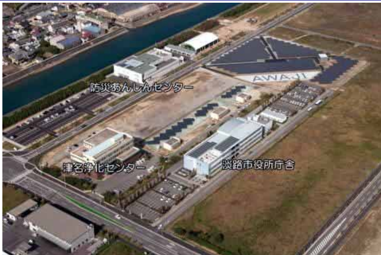
メガワットソーラー発電施設と淡路市役所庁舎等 出典：淡路市HP
