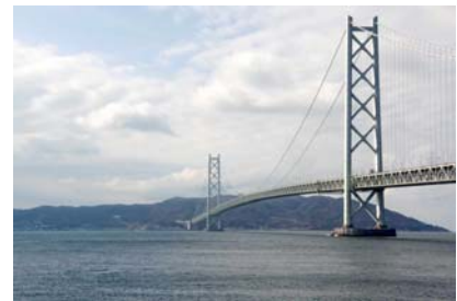
明石海峡大橋
