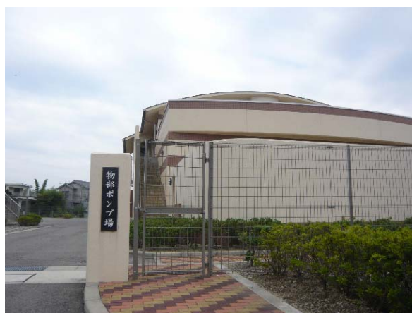
物部ポンプ場（洲本市）
