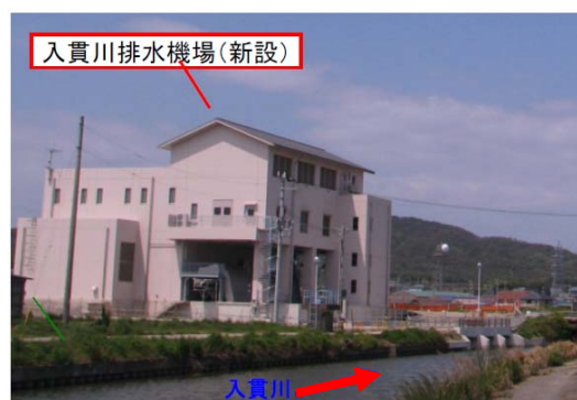
入貫川排水機場（南あわじ市松帆地内）
