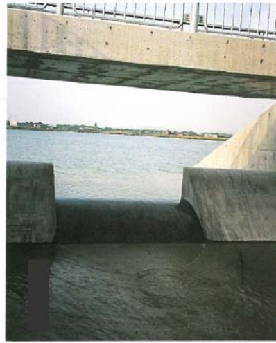
「洪水吐越流状況」
