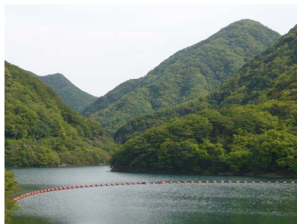
鮎屋川ダム貯水池（洲本市）
