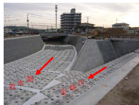
志筑川放水路(建設中)と 宝珠川の合流部
