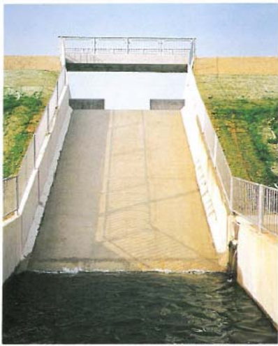
「洪水吐完成写真」
