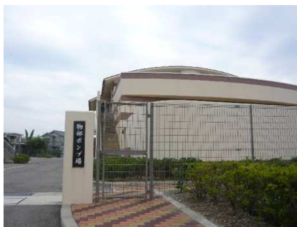
物部ポンプ場（洲本市）
