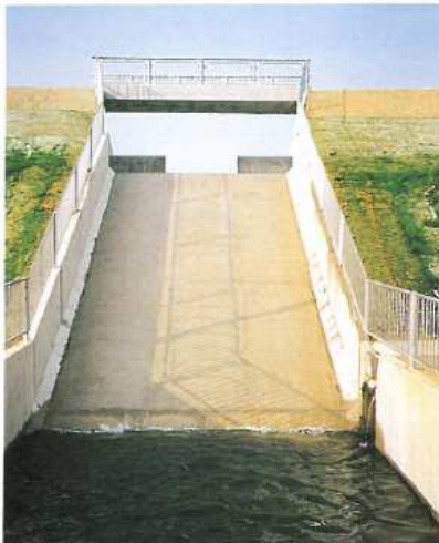
「洪水吐完成写真」
