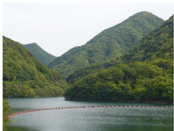
鮎屋川ダム貯水池（洲本市）
