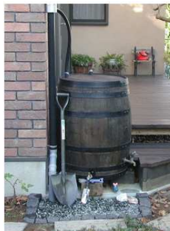
図 38 各戸貯留施設の例(地上タイプ)
